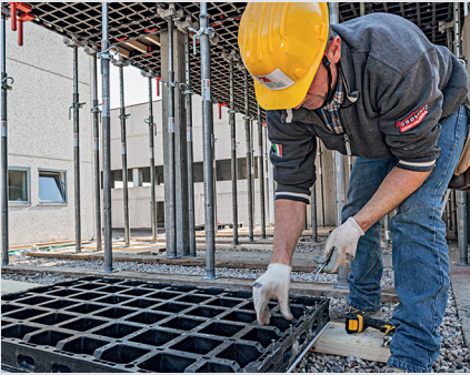
4. 用螺絲將新面板鎖緊
