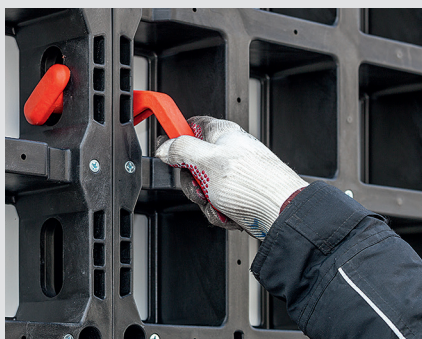
這種連接方式可以確保所有模板都處於同一平面。
