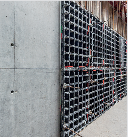
由於混凝土基本不會沾黏模板，所以模板可以從施工中的混凝土上輕鬆移除。這一點確保了混凝土表面的完美度。
