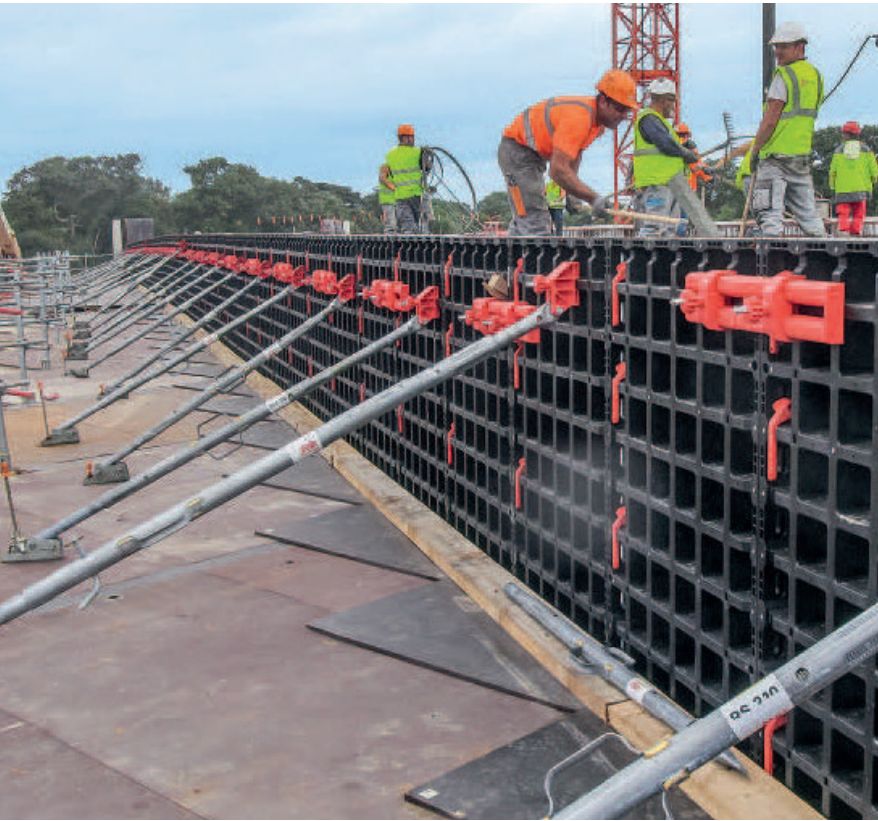
DUO 面板尺寸較小且操作簡單, 是澆置地基的不二之選。
