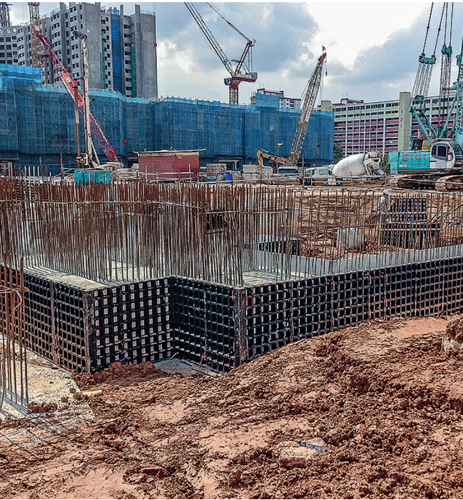
DUO 模板非常適合用於建造表面要求不高的小型混凝土結構。
