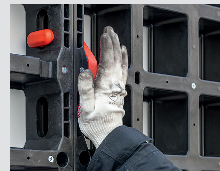
由於鎖扣與模板齊平, 所以可以將較大的預組模板組裝的十分平整。
