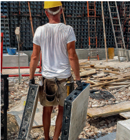
DUO 在框架中具有符合人體工程學的開口, 專為安裝模板連接器而設計。在建築工地上運輸元件時, 這些開口也可用作凹槽。
