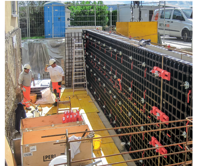
使用 DUO 可以在不使用吊車的情況下完美實現修正和擴展工作。
