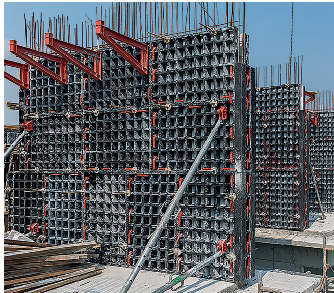
輕量系統模板首次成功用於建造剪力牆。
