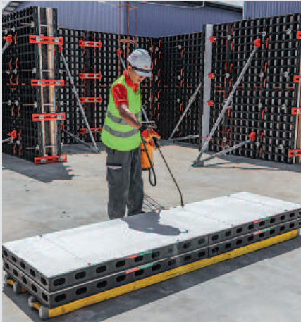
配合壓力噴霧器輕鬆使用派利 Plasto Clean 脫模劑
