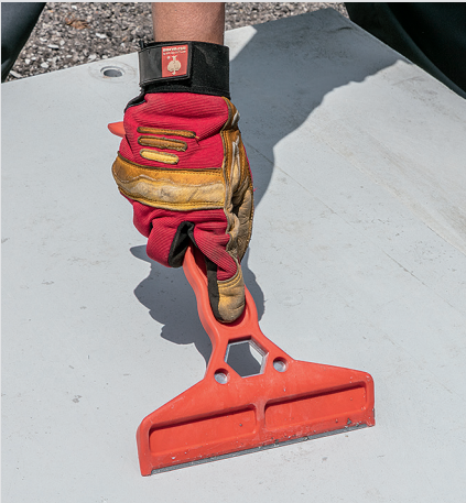
施工後使用 DUO 模板清潔工具進行清理。使用此工具可以輕鬆清除混凝土殘留物。
