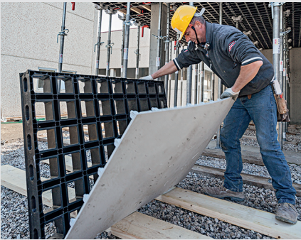
2. 移除損壞的面板
