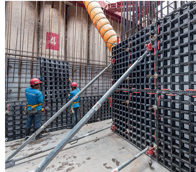
模板構件重量輕、尺寸多樣 - DUO 系統通過這些地下室牆模充分展示了這些優勢。
